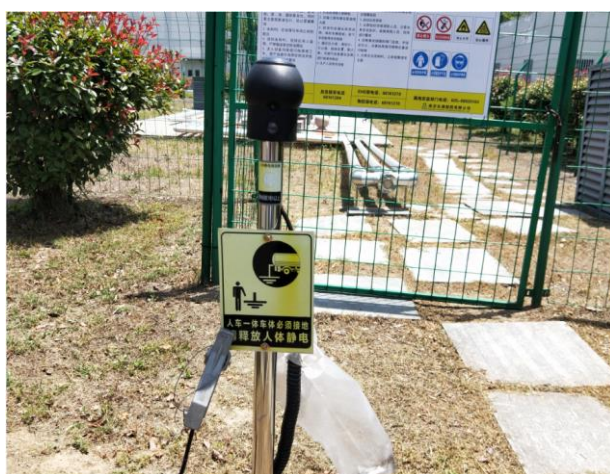
乙醇储罐区释放静电装置
