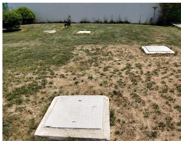
初期雨水收集池
