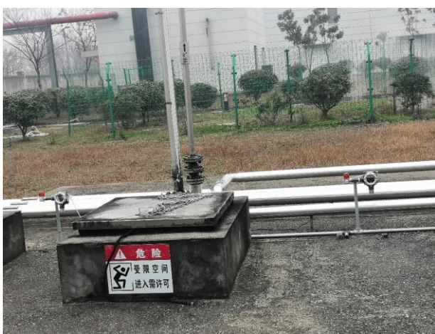
乙醇储罐可燃气体探测器
